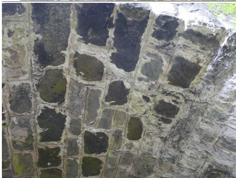
Foto č. 3 Konstrukce K 01 – podhled – výluhy pojiva
