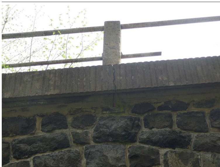
Foto č. 4 Konstrukce K 01 – římsa vpravo – svislá trhlina
